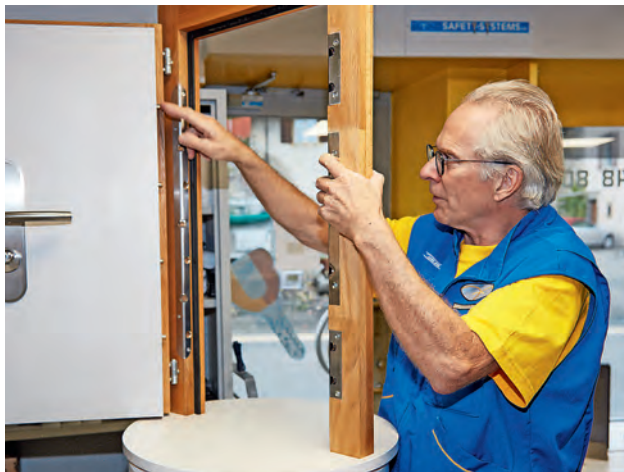
Hannes Eltrich zeigt an der Mustertür auf die Bandsicherung, die Teil einer Nachrüstung sein kann.
