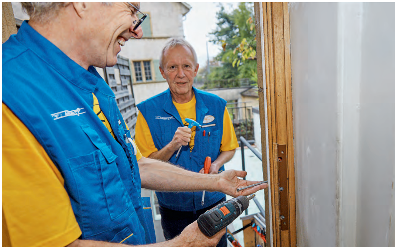
Ein robuster Beschlag ist das eine, das andere ist die feste Verankerung des Schliesspunkts im Mauerwerk: Hannes Eltrich (l.) mit Mitarbeiter Erich Gerber, einem pensionierten Polizisten.
